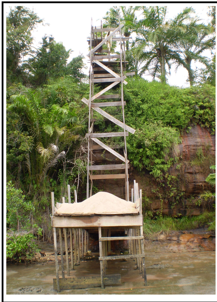
Foto 42 – Sistema de Elevação de Materiais de Construção
