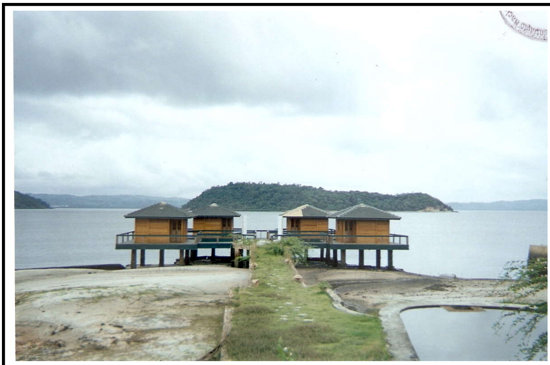
Foto 31 – Construções à margem do Corpo D'água
