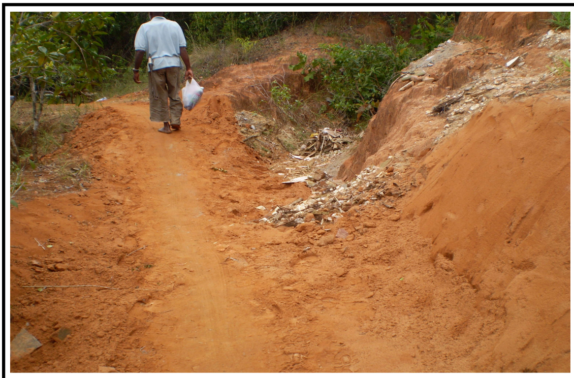
Foto 44 – Restos de Materiais de Construção em Propriedade
