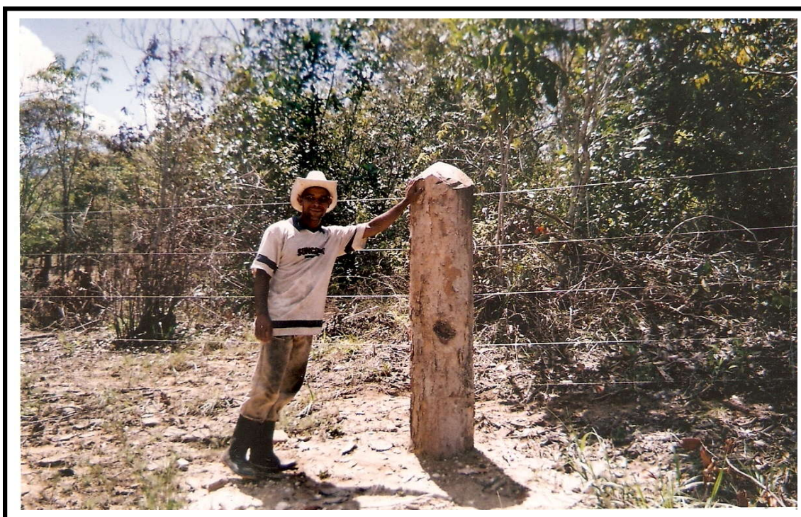
Foto 34 – Cercamento com Madeira não tratada
