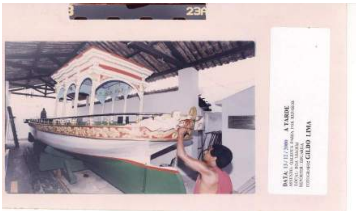
Figura 104: Reparos na galeota
